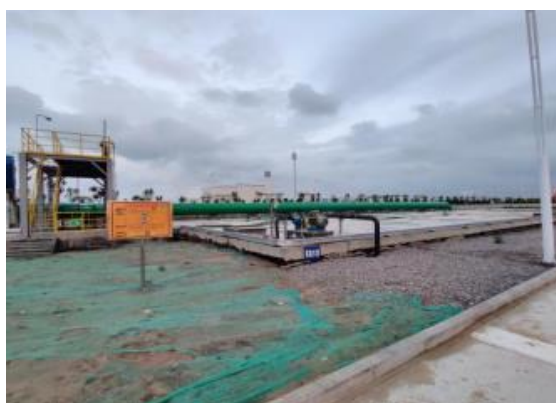
危废暂存库导排
